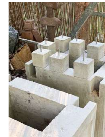
Die Armierungseisen werden nach dem Einbau in die Schalung mit Beton vergossen.
